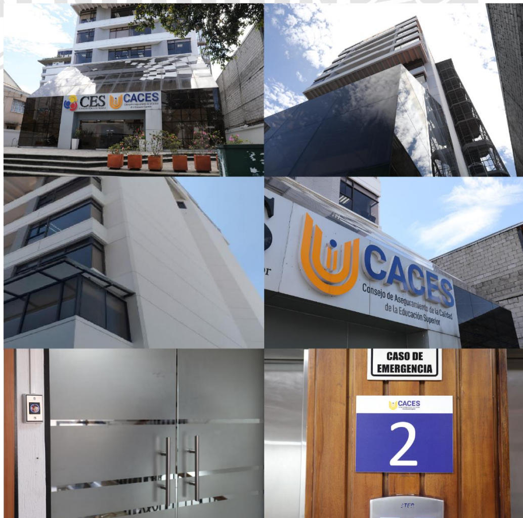
Adecuación de Edificio Cabrera Chávez
